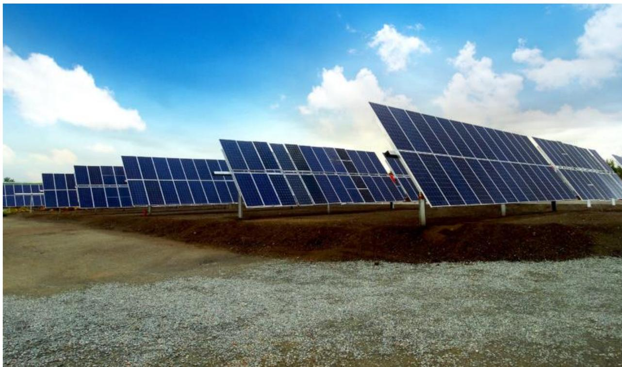
Figura 1 - immagine esemplificativa di inseguitori mono-assiali in configurazione 2P (fonte: Soltec)
